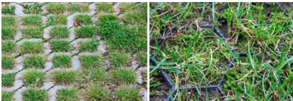
Figuur III.49: Grasbetontegels (links) en graskunststofplaat (rechts).
