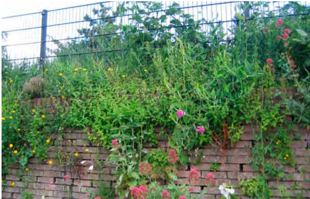
Figuur III.56: In het Griftpark in Utrecht werd een bakstenen keermuur gemetst van 220 m lang. Om zoveel mogelijk plantengroei mogelijk te maken, werden poreuze bakstenen en een zachte kalkhoudende specie gebruikt. In de muur zijn 4000 gaten opgehouden. De planten zijn door buurtbewoners aangeplant. De muur ligt op het zuiden en heeft maar een dun laagje grond aan de achterzijde. Om een weelderige plantengroei mogelijk te maken, werd geopteerd voor een beregeningssysteem met water uit de nabijgelegen vijver. Op de muur groeien o.m. Muurleeuwenbek ( Cymbalaria muralis ), Muurbloem ( Erysimum cheiri ), Grasklokje ( Campanula rotundifolia ) en Rode spoorbloem ( Centranthus ruber ) (foto: Heiligen Tonckens).
