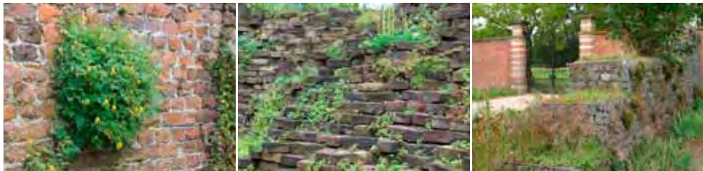
Figuur III.55: Muurbegroeiingen kunnen zowel op gemetste als op gestapelde muren voorkomen: links: gemetste muur met muurbegroeiing; midden: stapelmuur; rechts: begroeide schanskorven.
