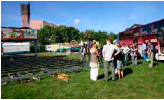
Figuur III.47: Opbouw van kermisattracties op een evenementenweide die bestaat uit een verharding van gazon-steenslag. Dit illustreert het potentiële grote draagvermogen en de stabiliteit van dit type verharding (Inden-Lamersdorf, Noordrijn-Westfalen, Duitsland).
