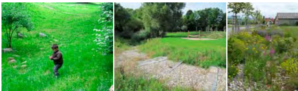
Figuur III.82: Wadi's worden doorgaans ingezaaid met gras en kort gemaaid (Wijk Kreuzberg, Berlijn, Duitsland). Een bloemrijke, kruidachtige beplanting is echter ook mogelijk: spontaan, door inzaai (midden) of aanplant (rechts) (links: Wijk Kreuzberg, Berlijn, Duitsland; midden: Malpertuus, Gent, foto: Fris in het Landschap; rechts: Willanzheim, Duitsland, foto: Eppel-Holz 2009).
