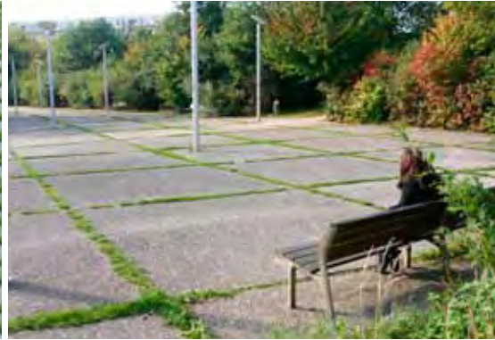
Figuur III.45: Brede, met gras ingezaaide voegen tussen grote betonnen dalen zorgen voor een sterk lijnenspel en geven een groene toets aan de verharding (Parc Matisse, Rijsel, Frankrijk).
